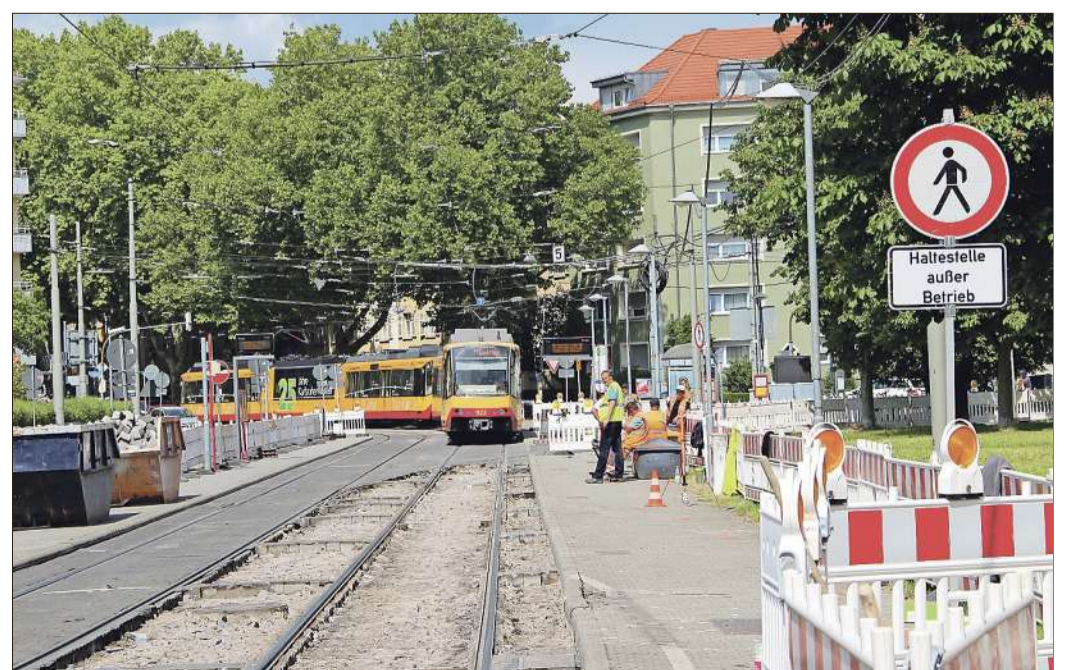
Am Tivoli in der Karlsruher Südstadt haben bereits die Vorarbeiten für den Gleis-Austausch begonnen. Foto: W. Heck
